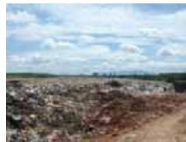
事業対象の廃棄物処分場
