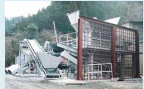
破砕切断施設
