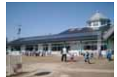
市民出資による太陽光パネル設置
