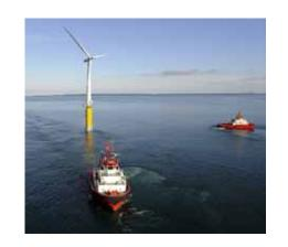
/ルウェーにおける実証の例 2009年9月より実証試験開始(2年間) 沖合10km 水深220mに設置 出力<u>2.3MW</u>、SPAR型
