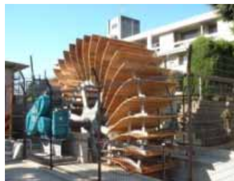
市民共同出資 による小水力 発電の設置
