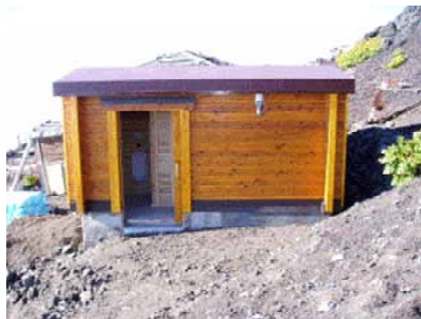
補助による山岳トイレの整備 (オガクズ式し尿処理施設)
