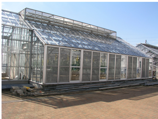
写真 7. 隔離栽培施設 (財)東京都農林水産振興財団農林総合研究センター江戸川分場 *注:現在は隔離栽培施設としては使用されていない。
