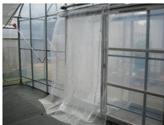
写真 6-2. 入口の拡大 二重扉に防虫用メッシュを併用している。
