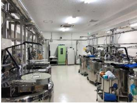
(LN タンク室)
