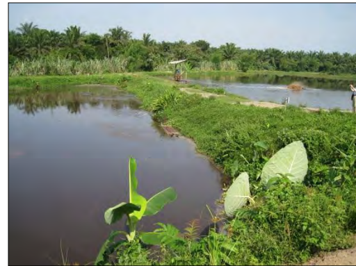
Gambar 2-3-9 Kolam oksida di pabrik PKS.
