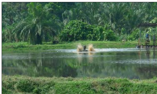
Gambar 3-1-4 Contoh kolam pengolahan biologi aerob dan aerator.
