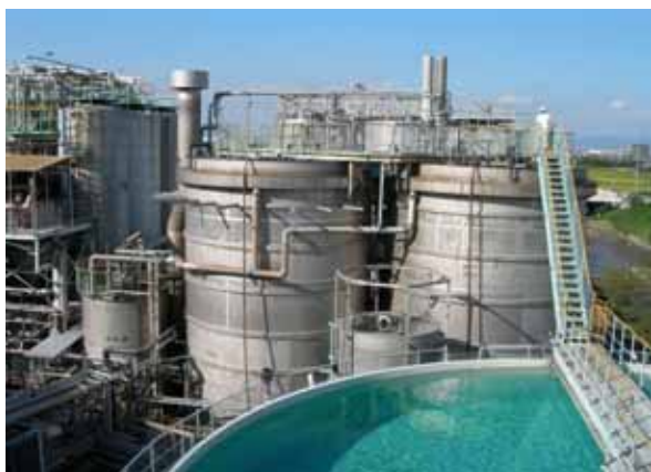
写真 異性化糖製造工程 UASB 嫌気性処理装置
