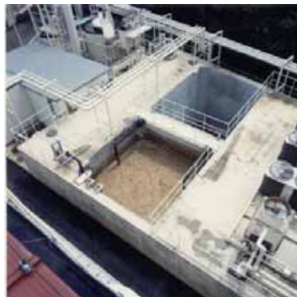
写真：製鉛製造工程排水制限曝気処理装置
