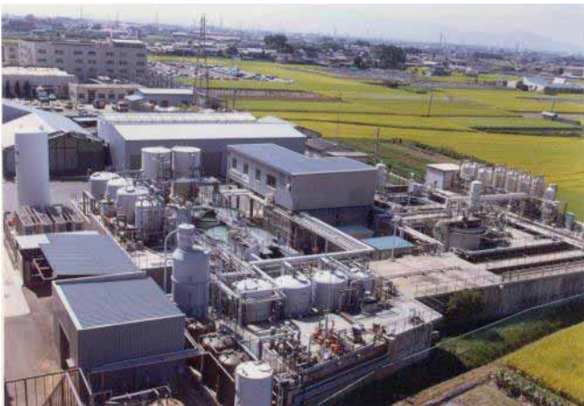
写真：電子部品製造工程排水処理装置
