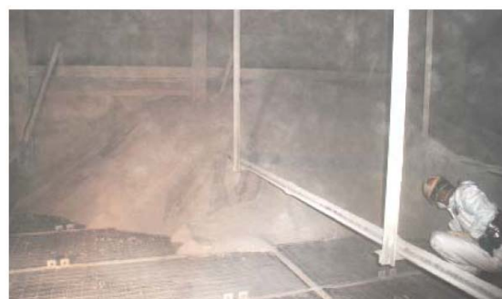
図4 脱硝装置入口部の灰堆積状態 引用：四国総研ニュース, Vol.9, 2009
