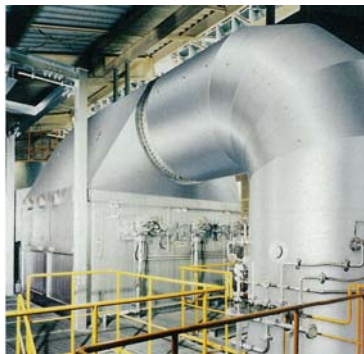
↑ 脱硝反応塔外観(一部)
