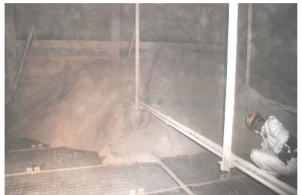
图4 脱硝装置入口部的灰堆积状态 引用: 四国综研新闻, Vol.9, 2009
