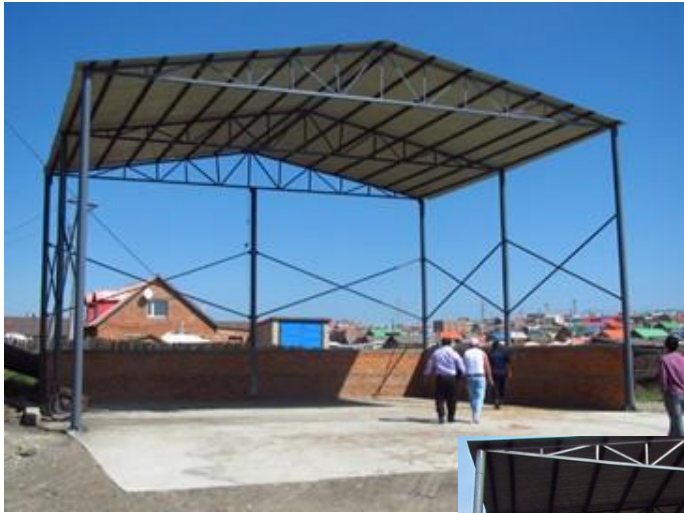
贮煤场全景 (上: 8月、下: 12月)
