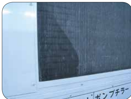
熱交換器の油のにじみ
