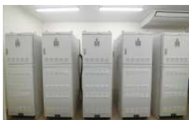
リチウムイオン蓄電池
