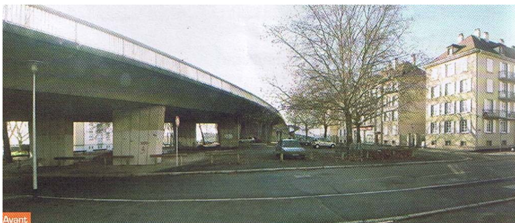
図2.3.4 高い橋桁があったチャーチル橋（車・自転車が利用していたが、すでに破壊済み）
