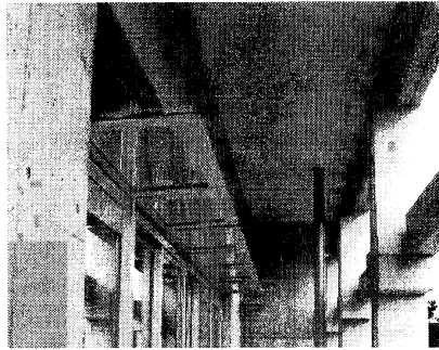
1) 南側排煙窓(室外から)
