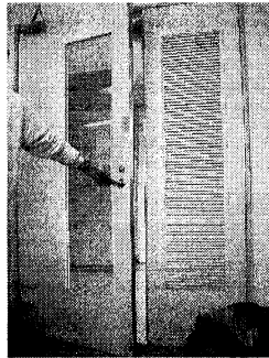
3) ドアガラリ(室内から)
