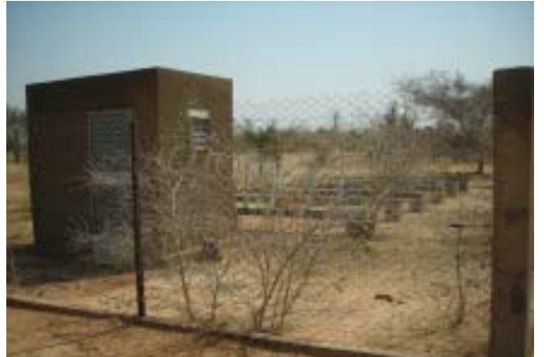
写真．太陽光パネルがすべて盗難にあった。
