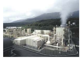
八丈島の地熱発電所
