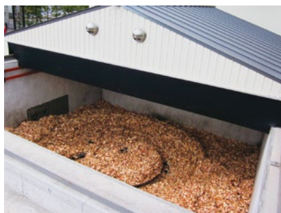
サイロ内のチップは落ちやすいようスクリーで回す
