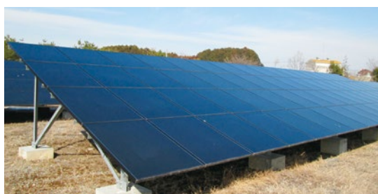
敷地内に設置された太陽光パネル
