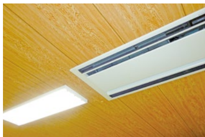
空調は全館、LEDは適所に設置
