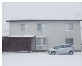
公共施設の屋根に太陽光パネルを設置（左上・上：村民センター分館、下：多目的会館）。
