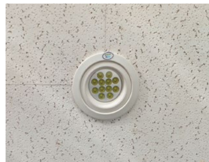
正面玄関入口に設置されたLED照明
