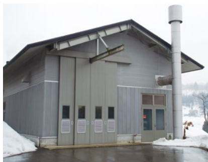
木質ペレットボイラー用の建屋
