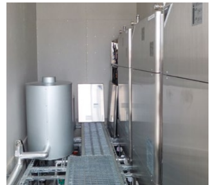
ヒートポンプが設置された機械室
