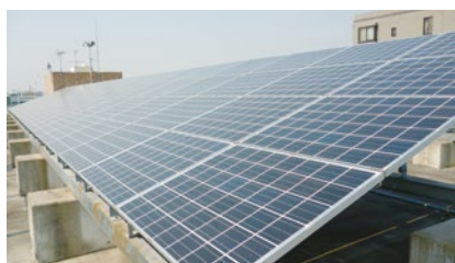
屋上に設置された太陽光パネル
