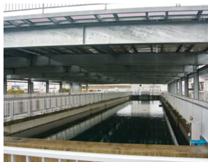
沈澱池を横から見る
