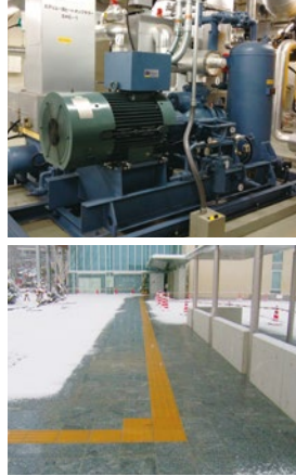
上: 地中熱ヒートポンプのある地下機械室 下: 地中熱を利用した融雪設備
