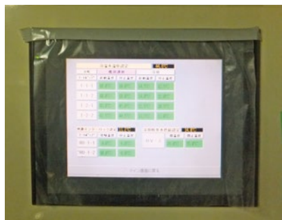
稼働状況が分かる制御盤
