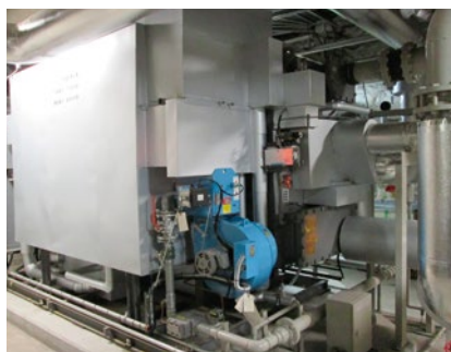
高効率ガス吸収冷温水機
