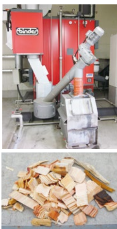
上: 含水率の高いチップも燃焼するオーストリア製ボイラー 下: スギやヒノキの切削チップを使用
