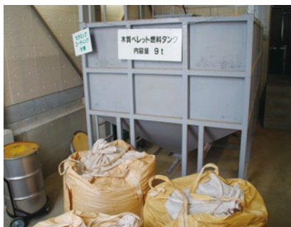
ボイラーに繋がっているペレットタンク
