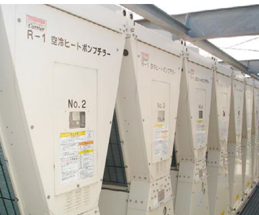
8台の空冷ヒートポンプチラーが稼働
