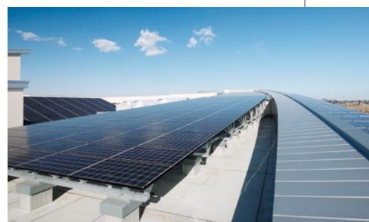
南向き・西向きに配置された屋上のパネル
