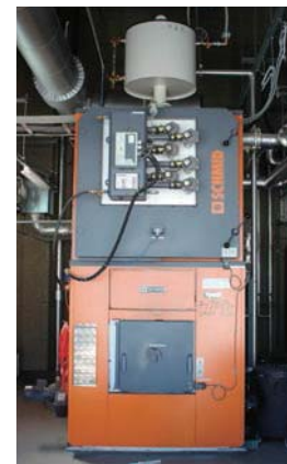
地域特性を生かせる木質バイオマスボイラーを採用
