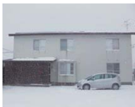
公共施設の屋根に太陽光パネルを設置（左上・上：村民センター分館、下：多目的会館）。
