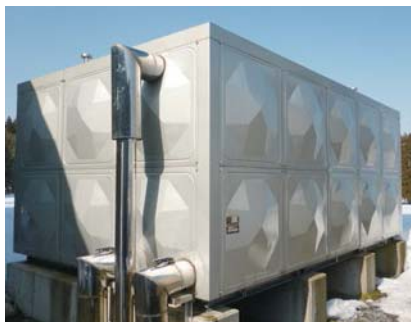
温泉熱・排熱を利用して熱回収
