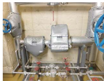
断熱ジャケットの装着で省エネ効果を高める
