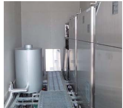
ヒートポンプが設置された機械室
