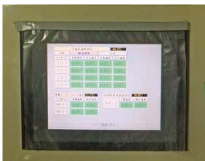
稼働状況が分かる制御盤
