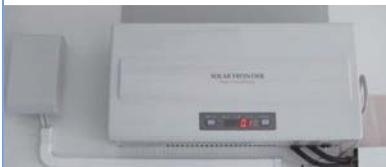
発電した電気を利用できるようにするパワーコンディショナー。
