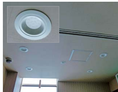
施設玄関の天井部を一部LED照明に
