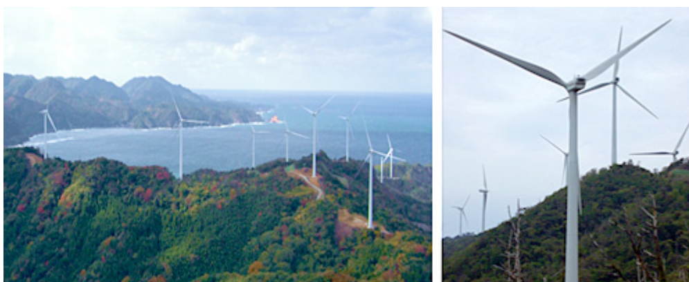
図 2.2-1 新出雲風力発電所
