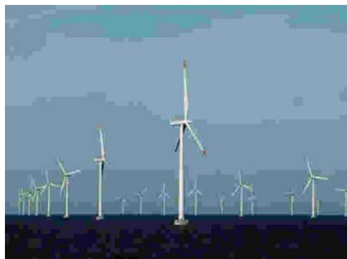
図 2.2-2 洋上風力発電稼働事例
