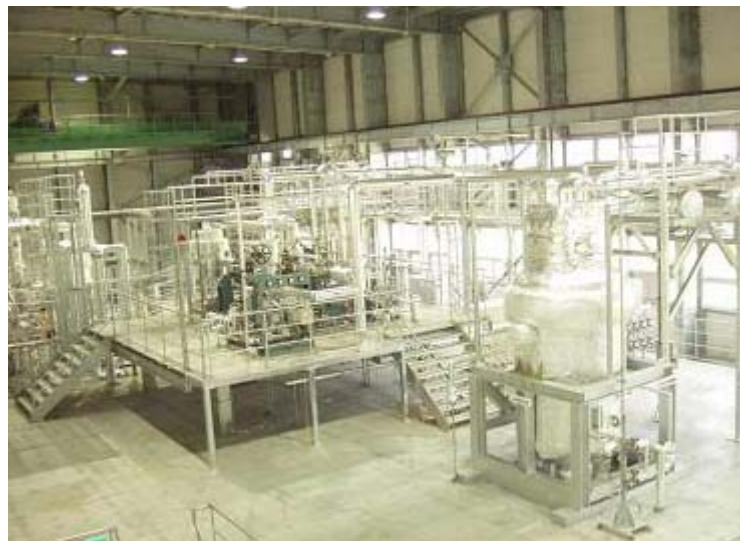
図 2.9-20 30kW 海洋温度差発電システム
