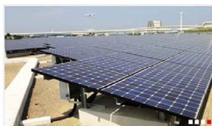
図 2.7-2 廃棄物埋立処分地におけるメガソーラー
