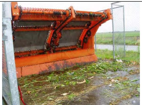
湯野沢分水工の除塵機(2010.6)
