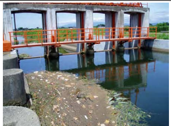
調査前の湯野沢分水工(2010.6)
