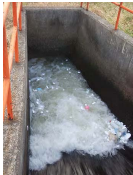
調査前の高坂サイホン施設
