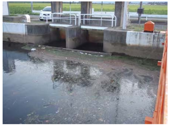
調査前の湯野沢分水工
