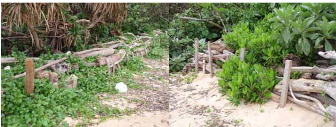
図 5.2-4 西表島で実施した流木の流出防止措置（杭による固定）
