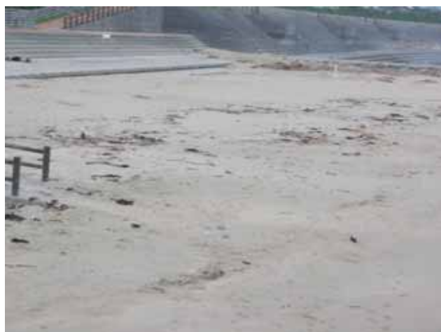
撮影方向②の海岸の状況（ズーム）
