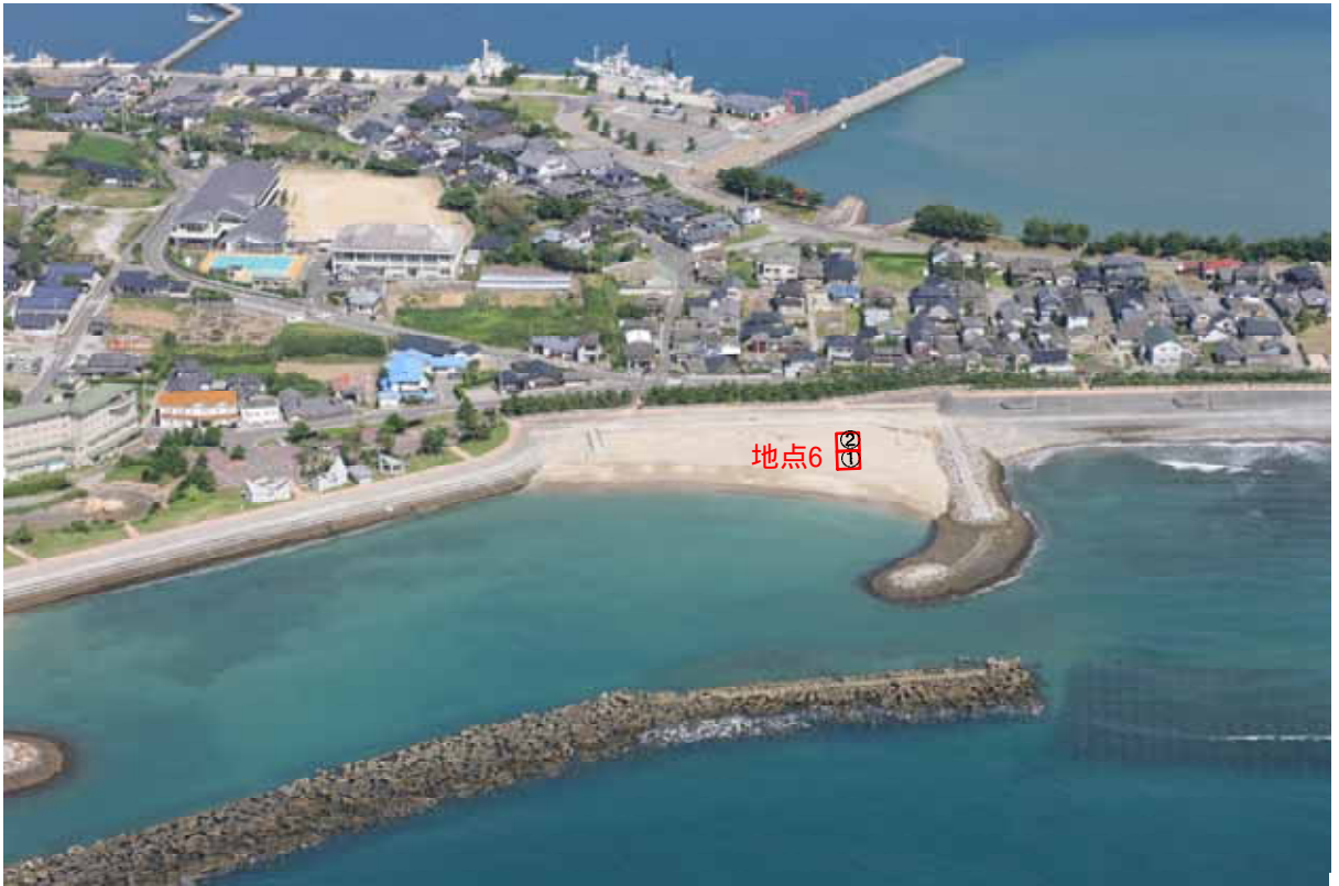
図 7.1-5(5) 調査枠の設置状況 (地点6)
