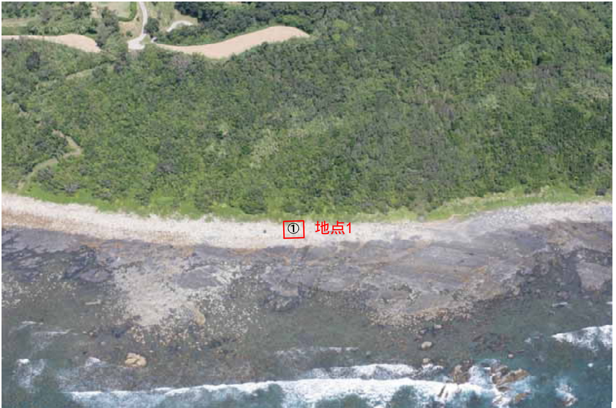
図 7.1-5(1) 調査枠の設置状況 (地点 1)
