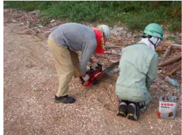
チェーンソーによる流木切断作業
