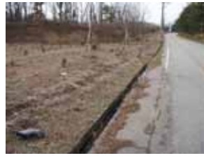
道路脇の状況
