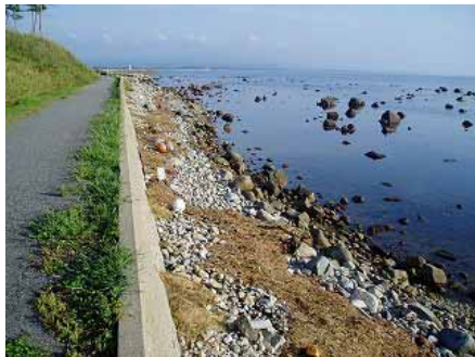
地点 7 の状況（現地踏査）
