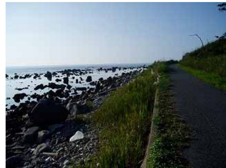
地点 7 の状況（現地踏査）
