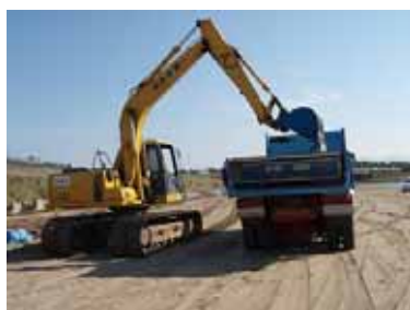
バックホウ、10tトラック
