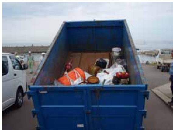
処理困難物の積み込み(安島地区)
