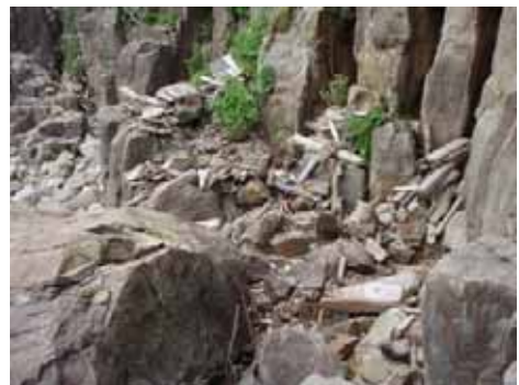
回収後(左の写真と逆方向から撮影)
