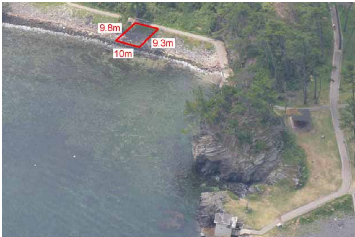
図 3.1-5(1) 共通調査枠の設置状況(地点 1: 験潮所)
