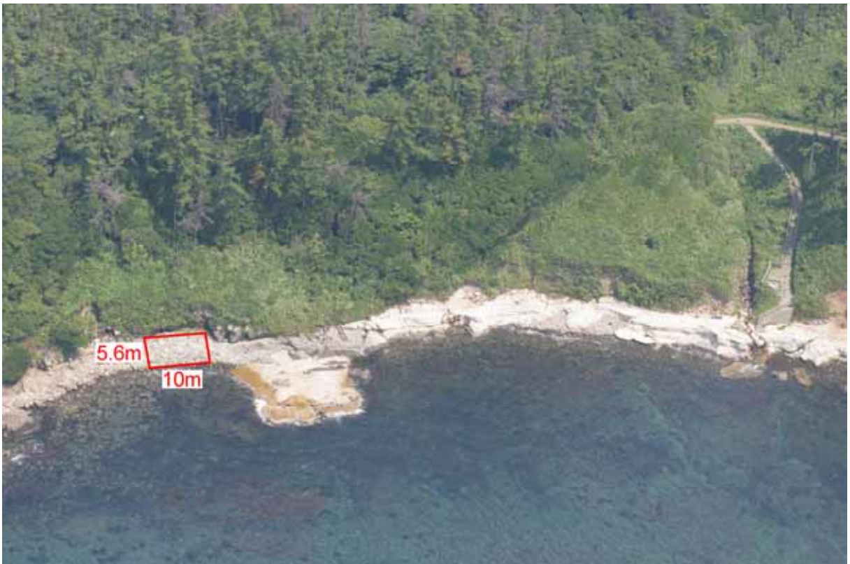
図 3.1-5(6) 共通調査枠の設置状況(地点 6:製塩所廃跡)
