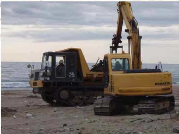
バックホウによる回収
