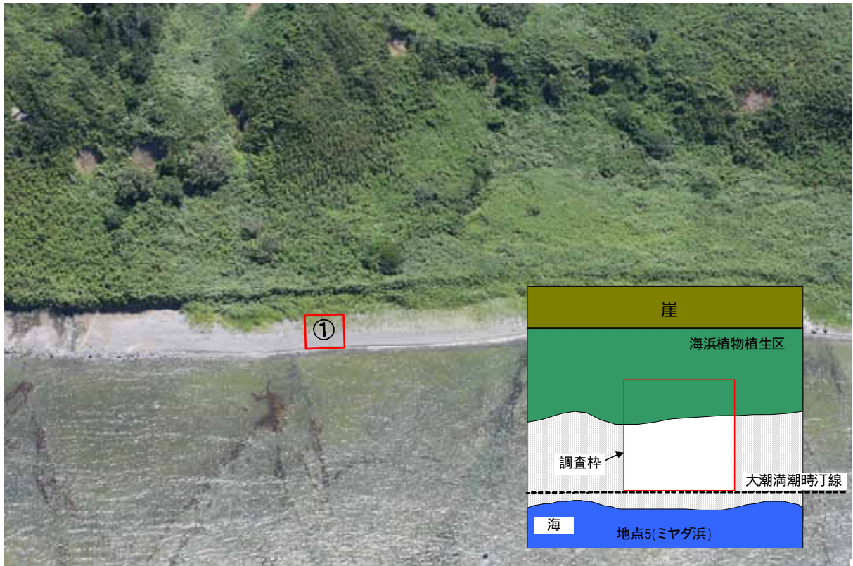
図 3.1-5(5) 共通調査枠の設置状況 (地点5 : ミヤダ浜)
