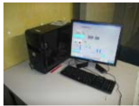
システム制御・監視システム
