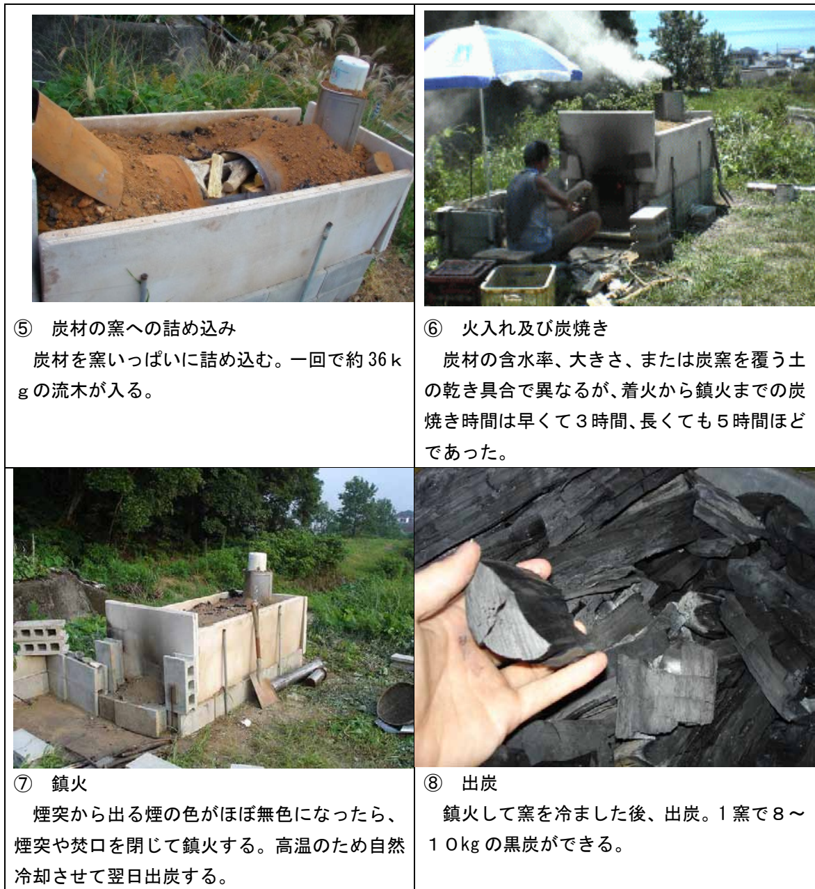
図 3.2-41 (2) 流木の炭化処理の作業の流れ
