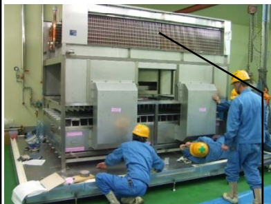
従来型システム 庫内蒸発器(クーラー)
