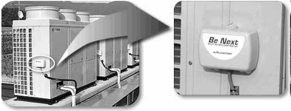
付図4 空調用圧縮機省エネルギー制御装置の設置例
