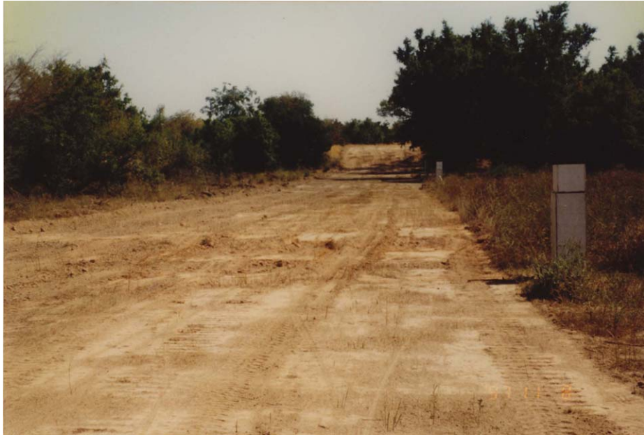
Photo 4.1: Travaux de construction du barrage souterrain - 1
