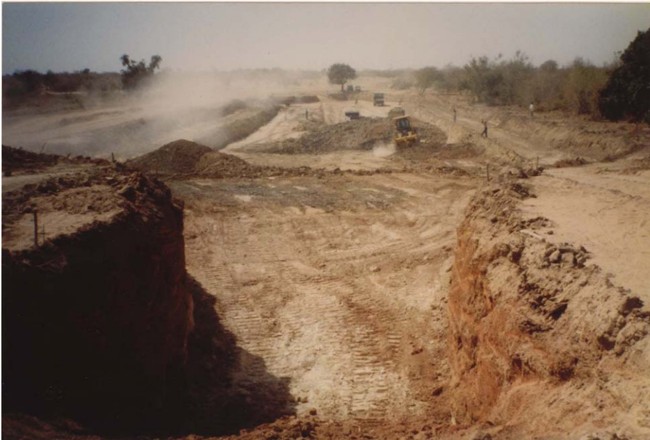
Photo 4.2: Travaux de construction du barrage souterrain - 2
