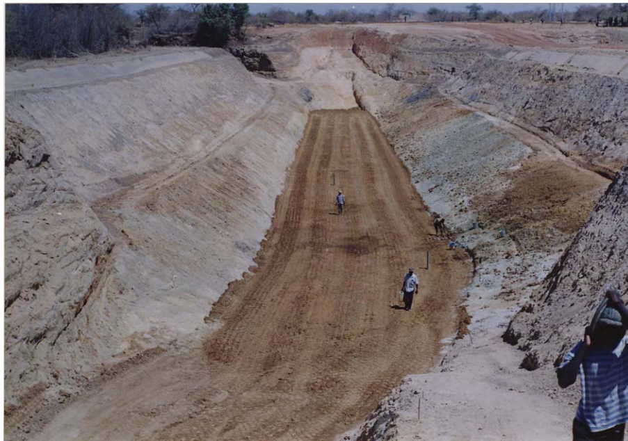
Photo 4.4: Travaux de construction du barrage souterrain - 4
