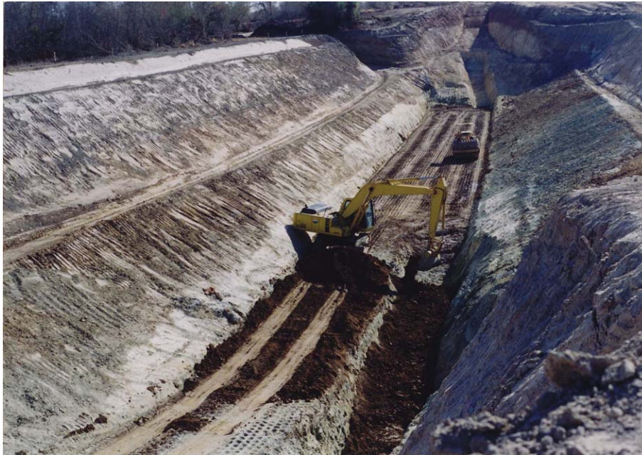
Photo 4.3: Travaux de construction du barrage souterrain - 3
