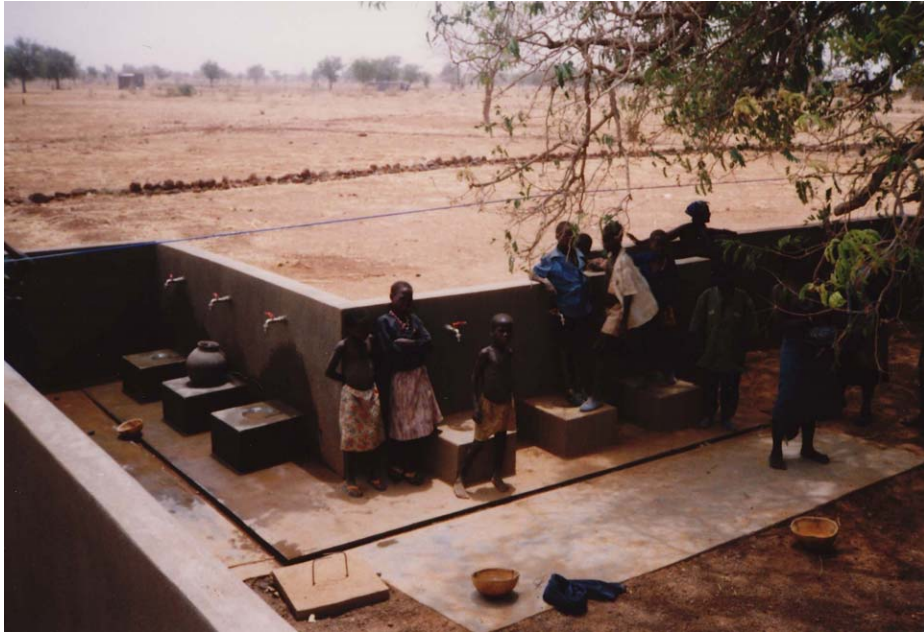
Photo 7.3: Installation d'alimentation en eau domestique construite au village de Kombang-bedo
