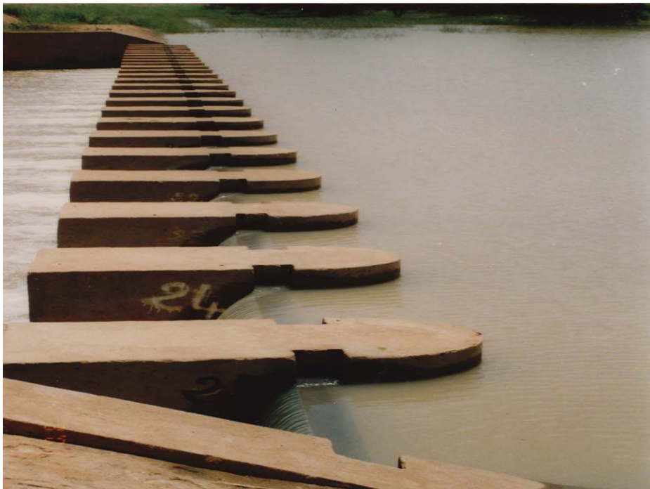
Photo 7.5: “Ecluse (micro barrage à vannes)” installée par le projet
