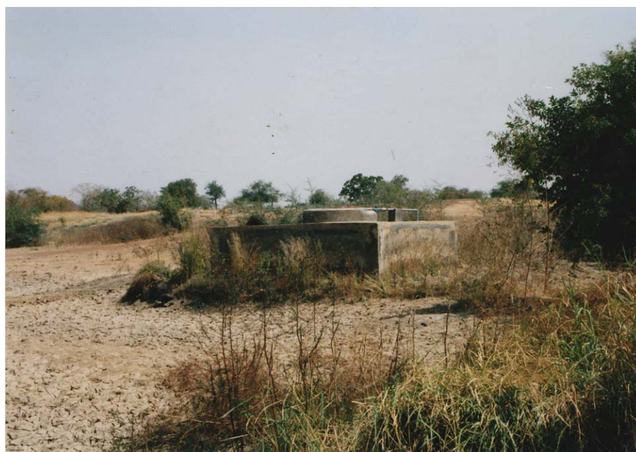
Photo 7.2: Puits de pompage installé dans la zone du réservoir du barrage souterrain (Des murs de béton sont coulés autour du puits pour le protéger contre les crues)
