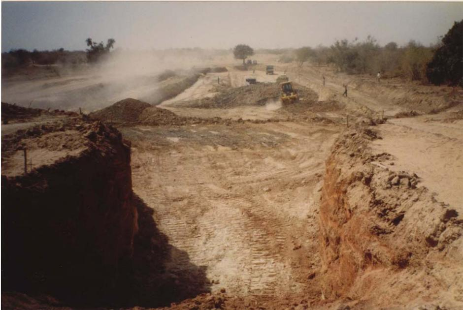
Photo 4.2: Travaux de construction du barrage souterrain - 2
