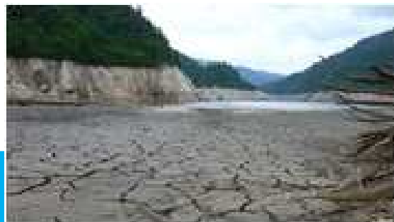
平成28年の渇水時の矢木沢ダム（群馬県） 出典：「平成29年度水循環施策」
