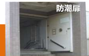
地下鉄出入口の浸水対策
