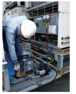
スーパーマーケット冷蔵ショーケース(室外機)からのフロン類冷媒回収の様子 写真提供: 冷媒回収推進・技術センター
