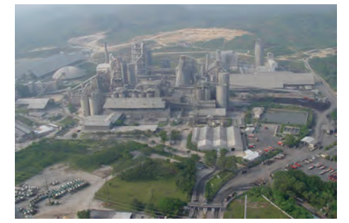
日本環境省の協力によりフロン破壊施設を設置したインドネシアのセメント工場
