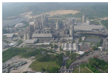
日本環境省の協力によりフロン破壊施設を設置したインドネシアのセメント工場
