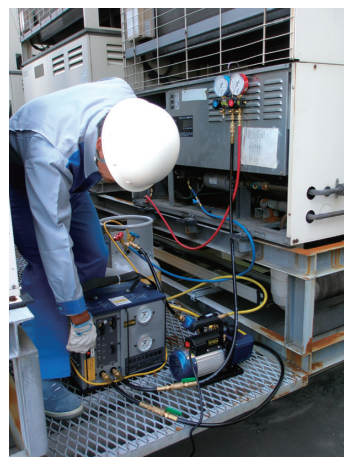
スーパーマーケット冷蔵ショーケース(室外機)からのフロン類冷媒回収の様子
