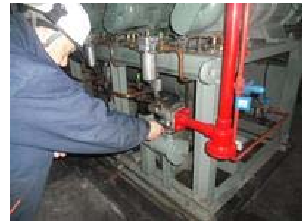
高性能な漏洩検知器にて配管接続部を確認
