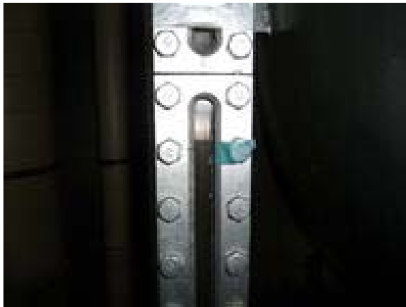
液面計にて冷媒量確認
