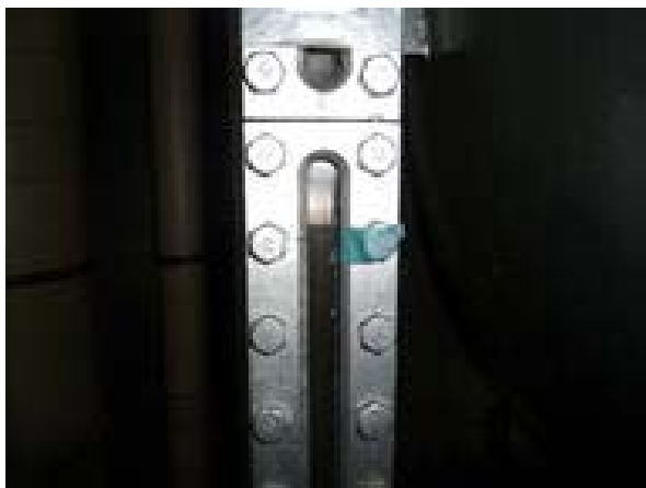
液面計にて冷媒量確認
