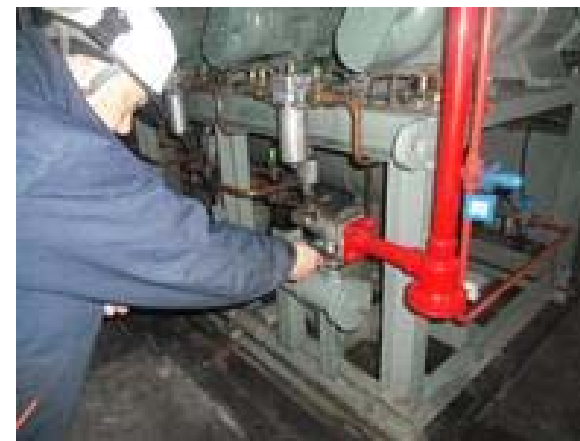
高性能な漏洩検知器にて配管接続部を確認
