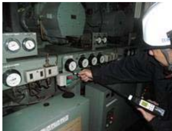
高性能な漏洩検知器にて配管接続部を確認
