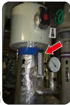
冷却水及び冷水の出入口温度
