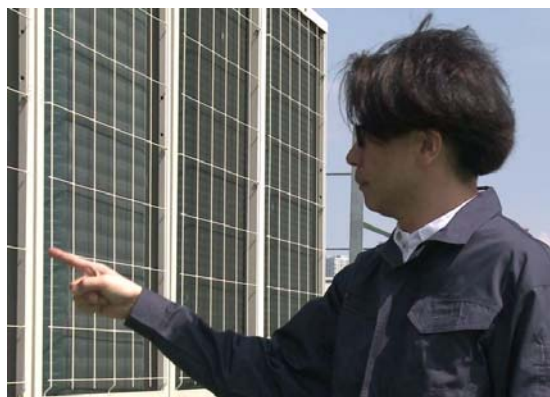
室外機を目視点検
