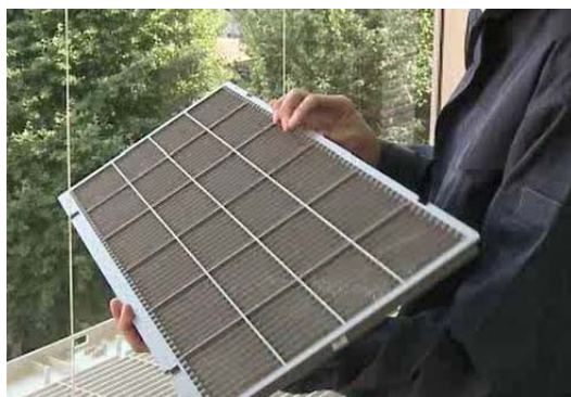
フィルタを目視点検
