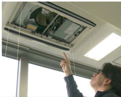
室内機を目視点検
