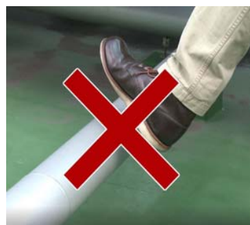
冷媒配管の防熱を踏まない
