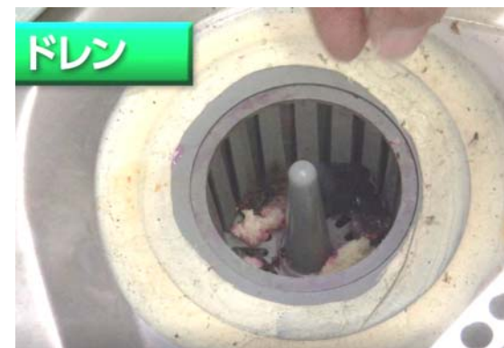
ショーケースのドレン点検
