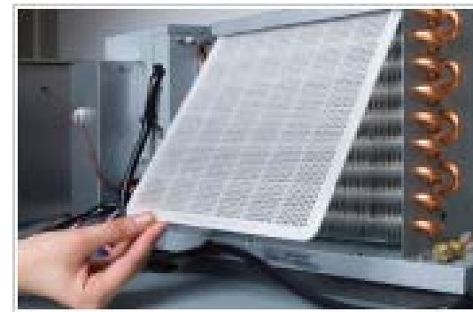
業務用冷蔵冷凍庫 フィルタ清掃
