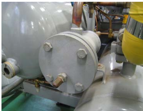
④ 機械式継手とフランジ
