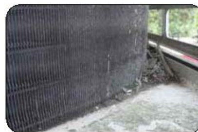
熱交換器下部の腐食
