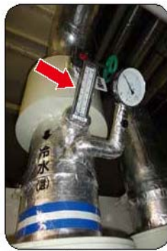
冷却水及び冷水の出入口温度
