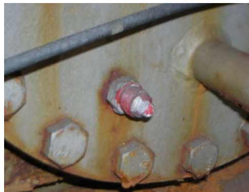
④ 機械式継手とフランジ
