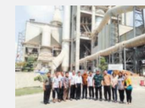
セメント廃熱回収発電
