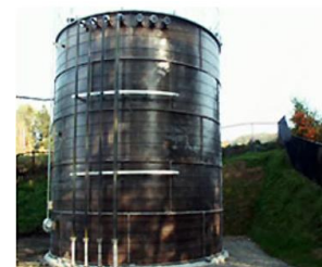
貯湯槽（保温前）
