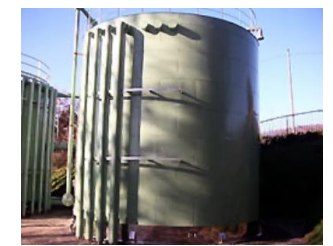
貯湯槽（保温後）
