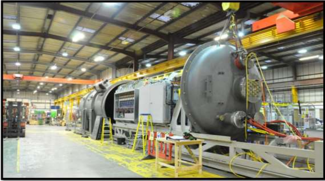
図 6.3-5 TCC 内部の電気制御盤
