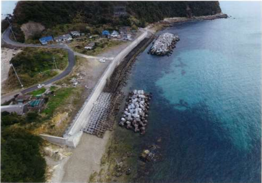
上空撮影写真1（全景）
